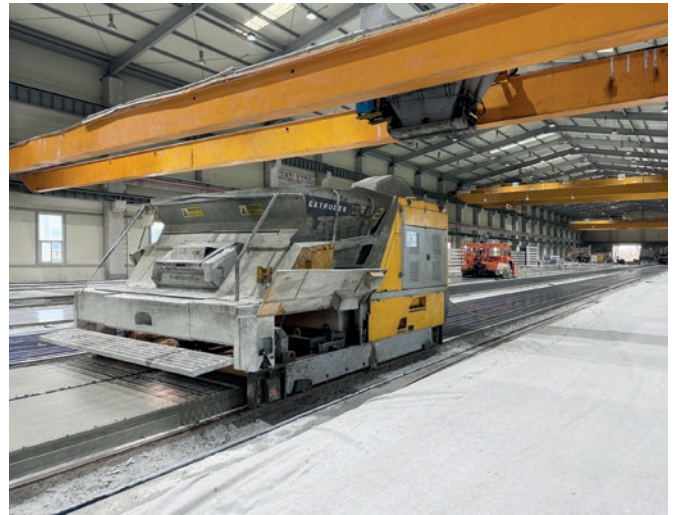
Extrusora EVO2 de 2,4 m para dos placas durante el hormigonado
